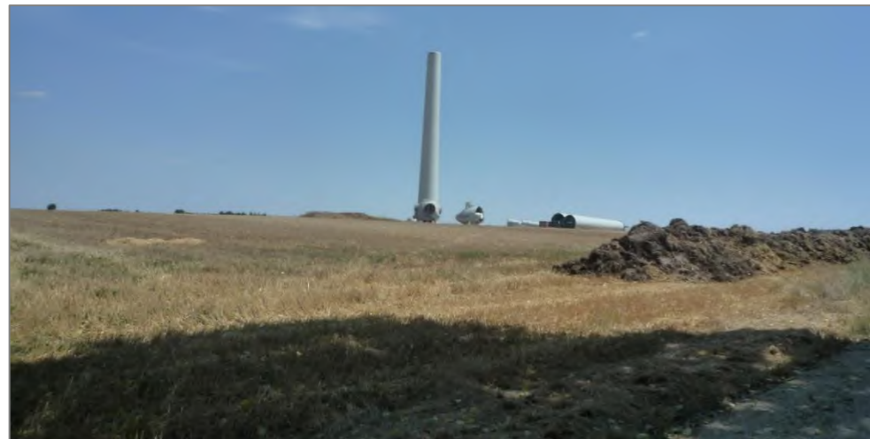
Photographie 57 : Exemple de stockage de terre durant un chantier éolien
