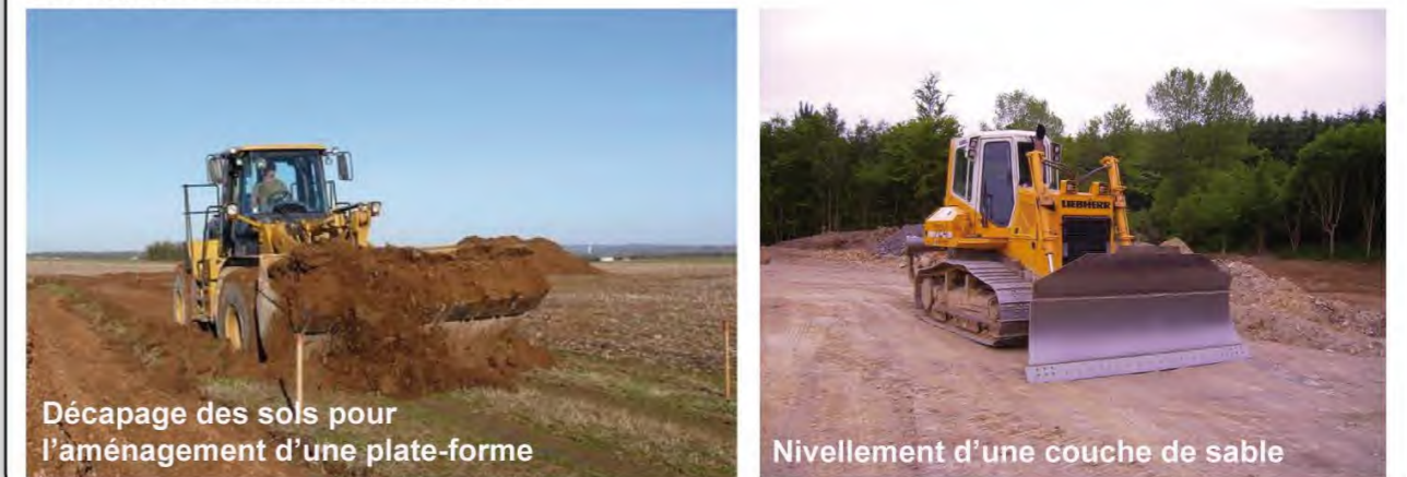
Photographie 51 : Exemples d'engins de travaux de VRD
