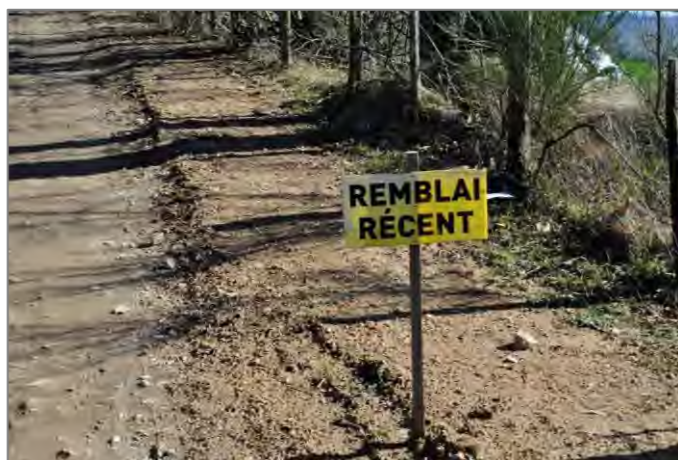
Photographie 58 : Exemple de remblai des tranchées électriques le long d'une piste
