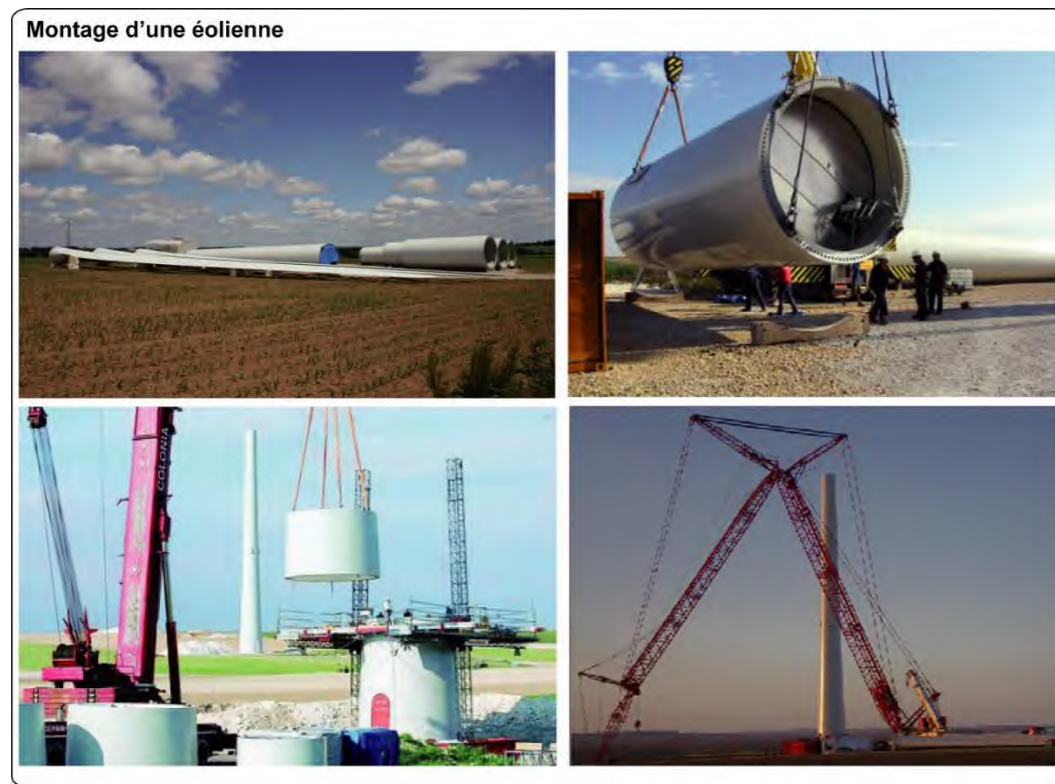
Photographie 54 : Phases d'assemblage d'une éolienne
