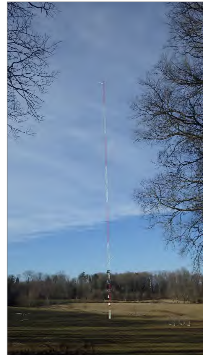
Photographie 1 : Mât de mesure installé sur le site
