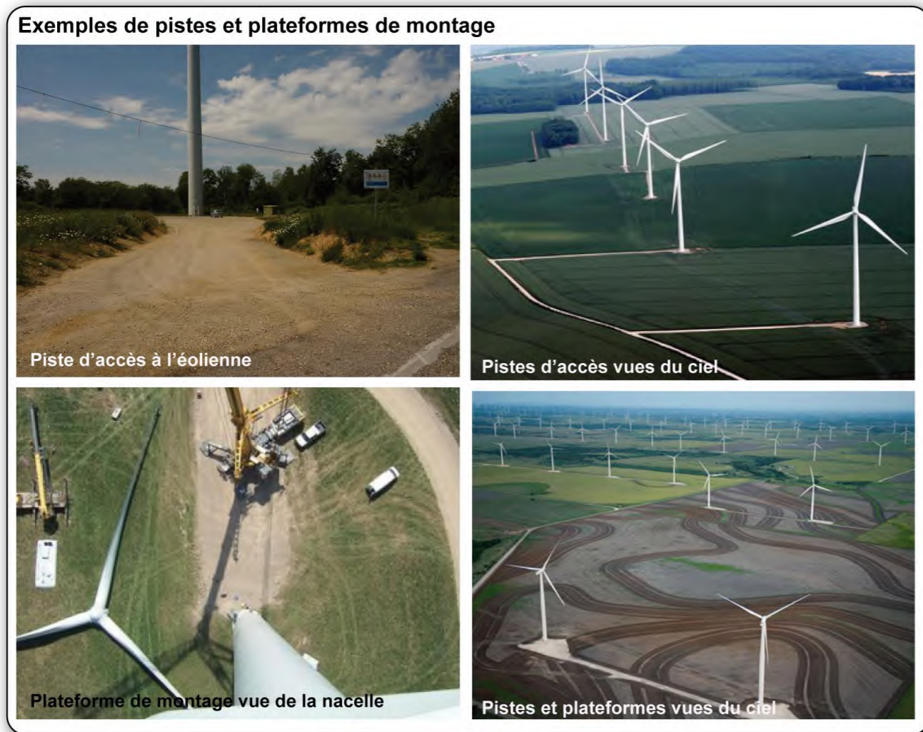
Photographie 45 : Exemples de plateformes de montage et de pistes
