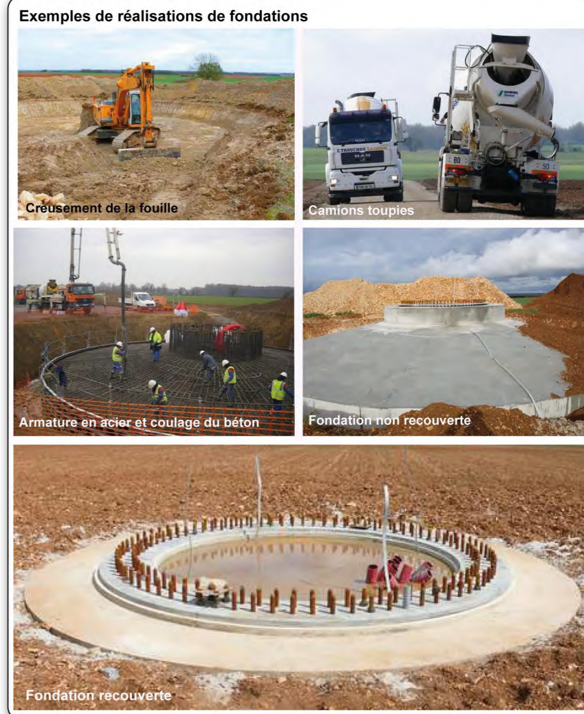
Photographie 52 : Etapes de réalisation d'une fondation d'éolienne
