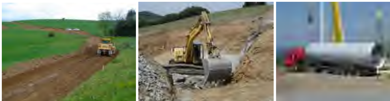
Photographie 60 : illustration d'un chantier éolien
